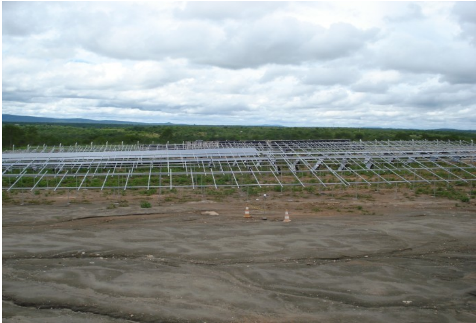
Dia 04 - 03 - 2011: Montagem dos Painéis
