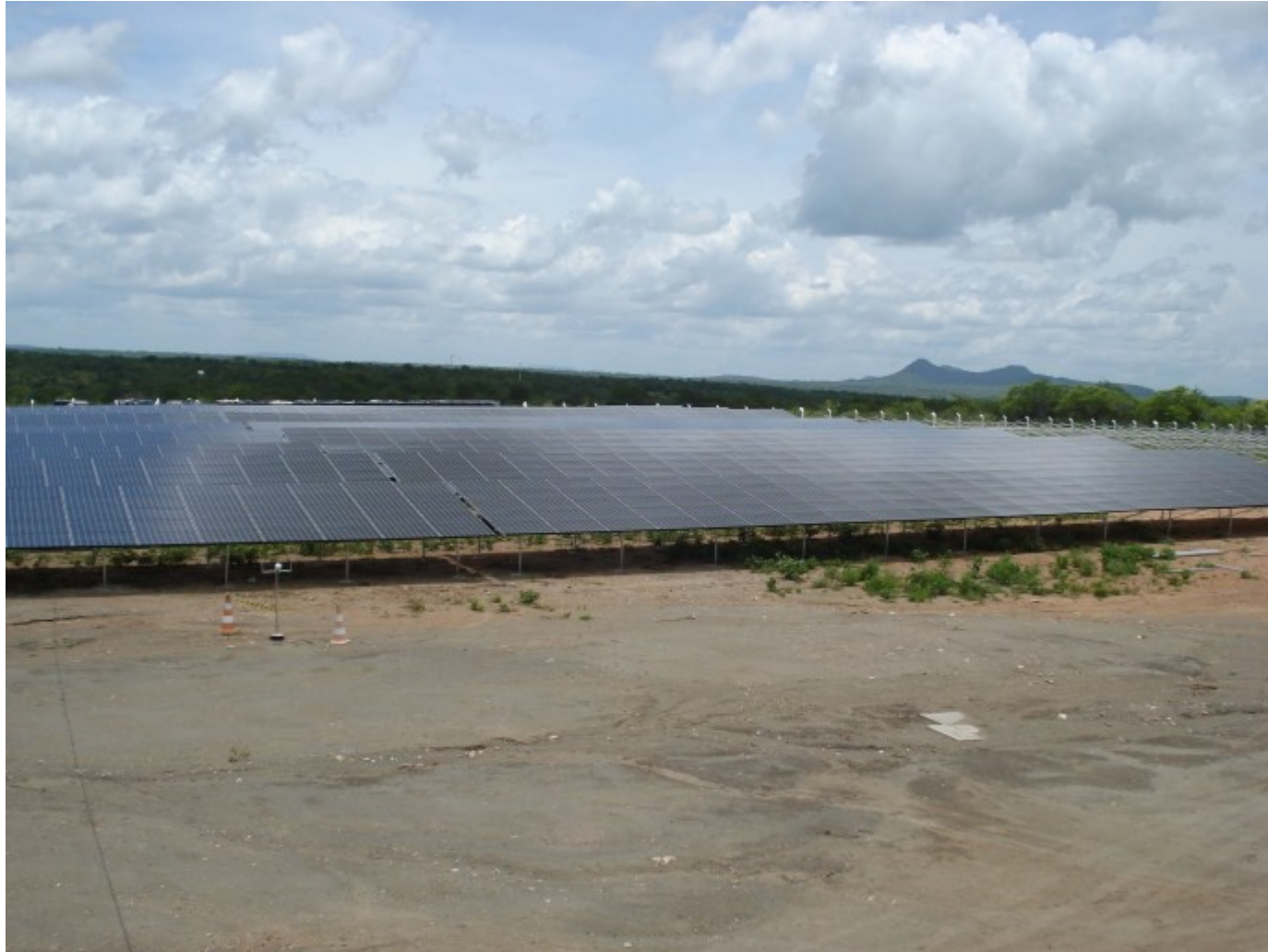
Dia 10 - 03 - 2011: Montagem dos Painéis
