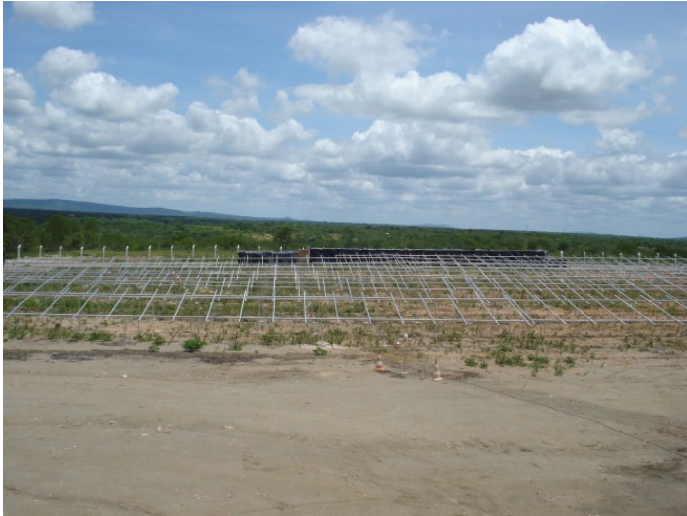
Dia 24 - 02 - 2011: Montagem das Estruturas Metálicas
