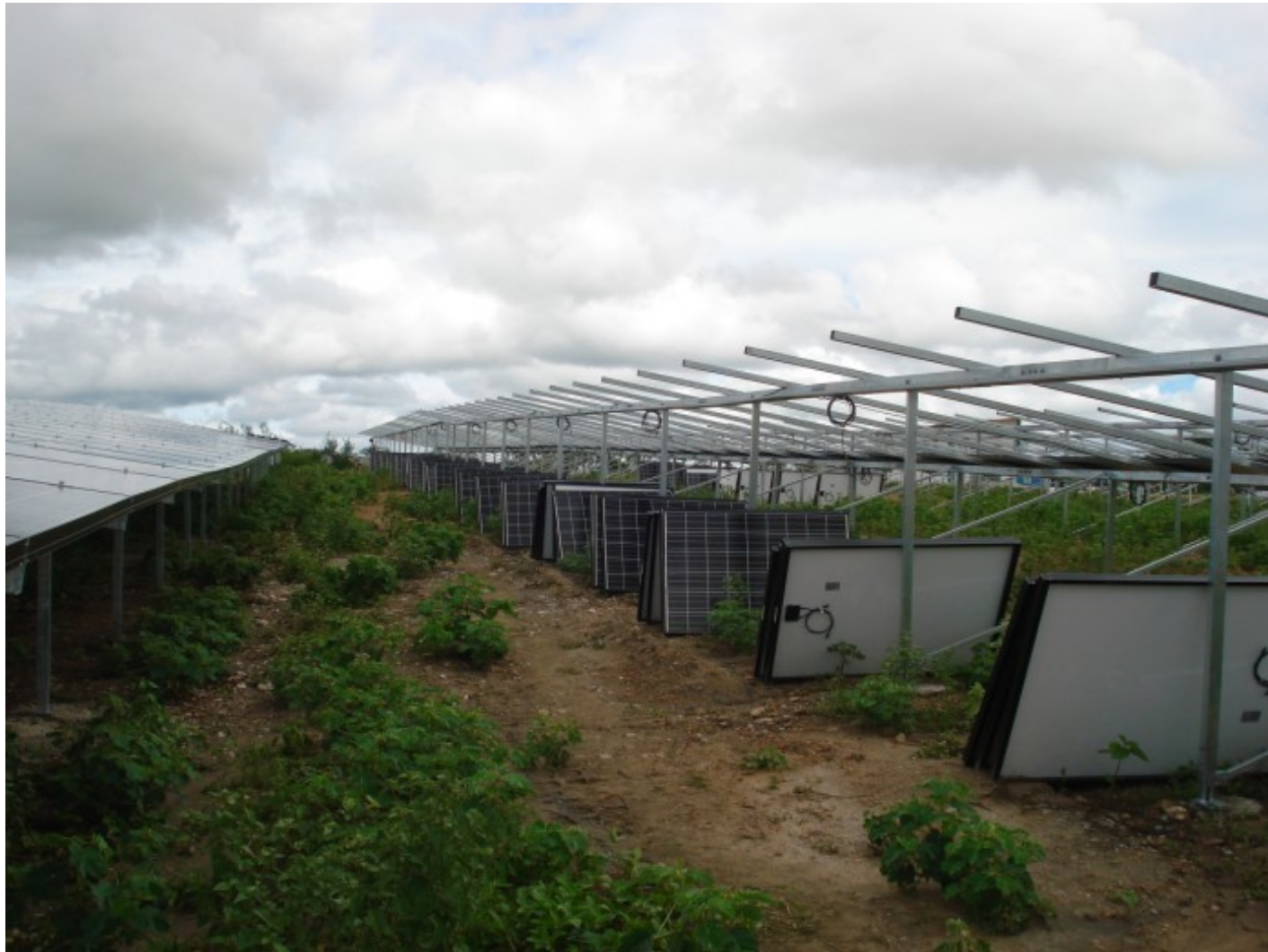
Dia 04 - 03 - 2011: Montagem dos Painéis
