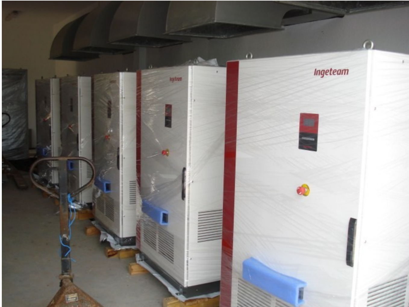
Dia 26 - 01 - 2011: Inversores chegam na obra
