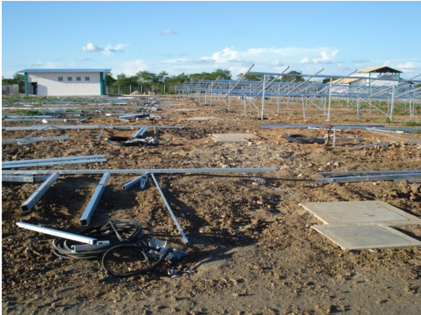
Dia 24 - 02 - 2011: Montagem das Estruturas Metálicas
