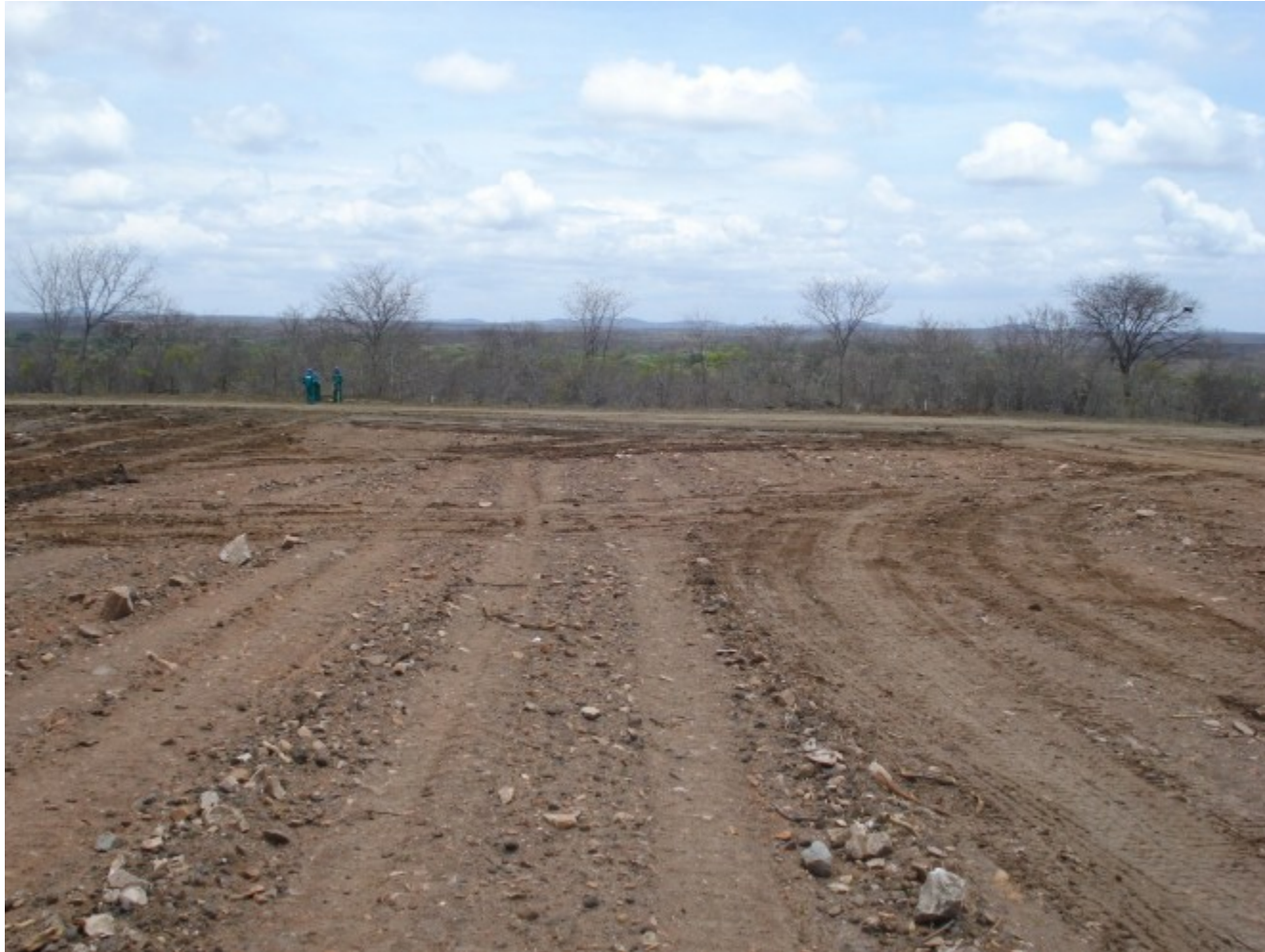
Dia 26- 10-2010: Terraplenagem da área dos painéis fotovoltaicos
