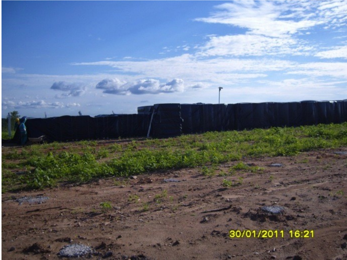
Dia 30 - 01 - 2011: Painéis Fotovoltaicos no site
