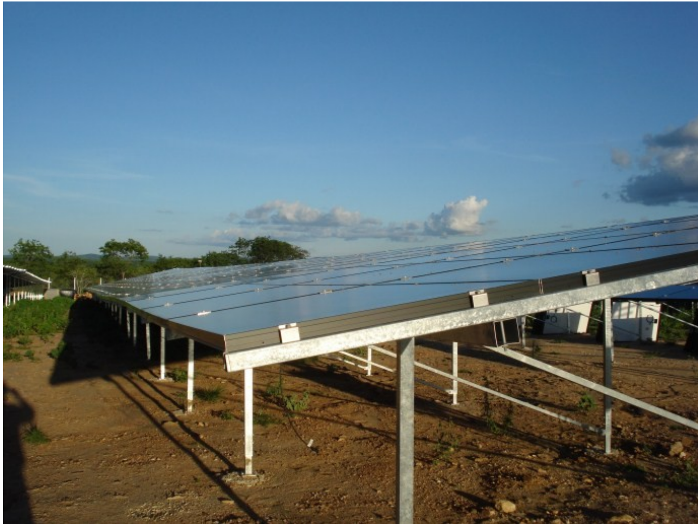
Dia 10 - 03 - 2011: Montagem dos Painéis
