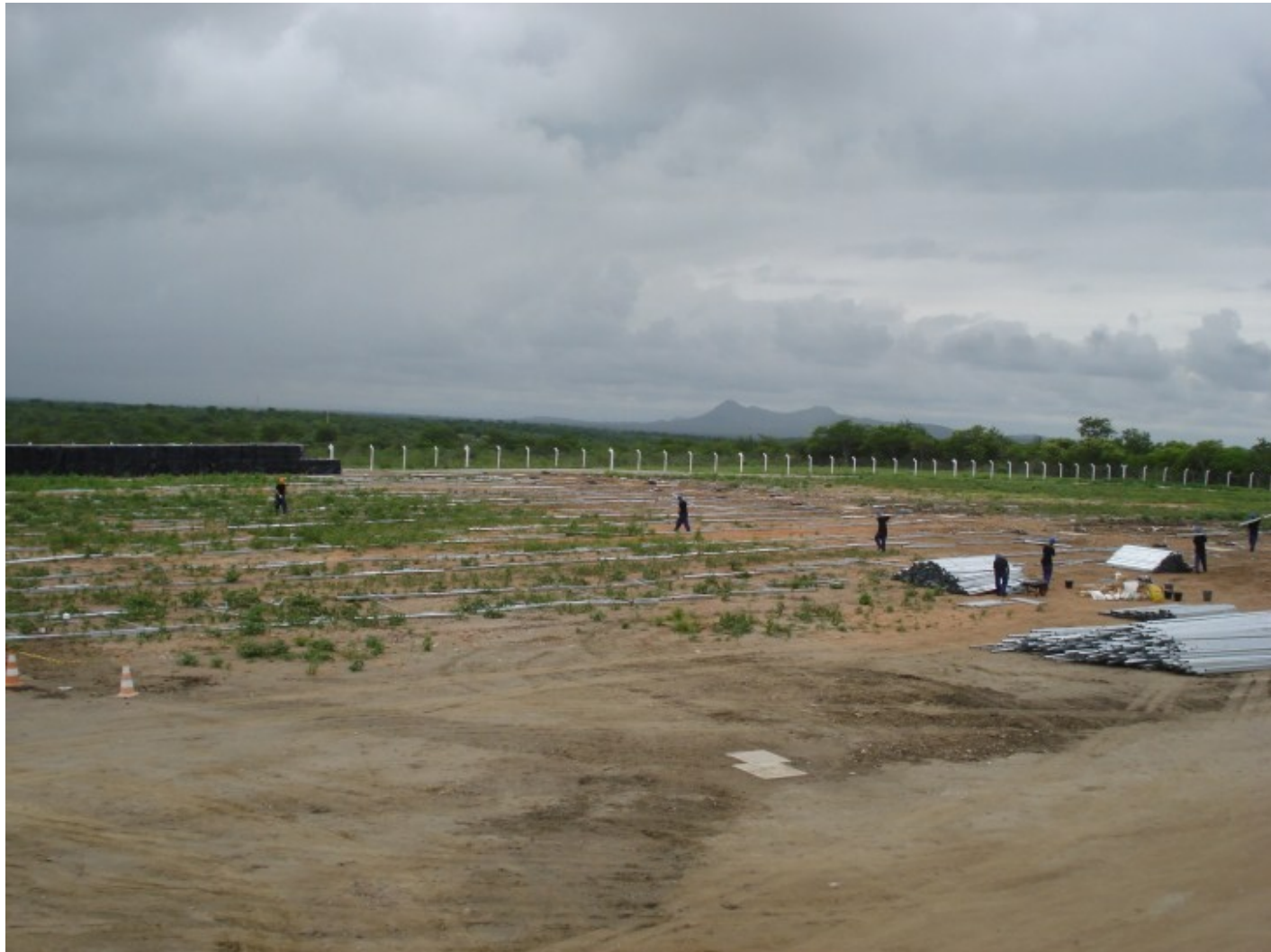
Dia 17- 02 - 2011: Montagem das Estrutura Metálicas
