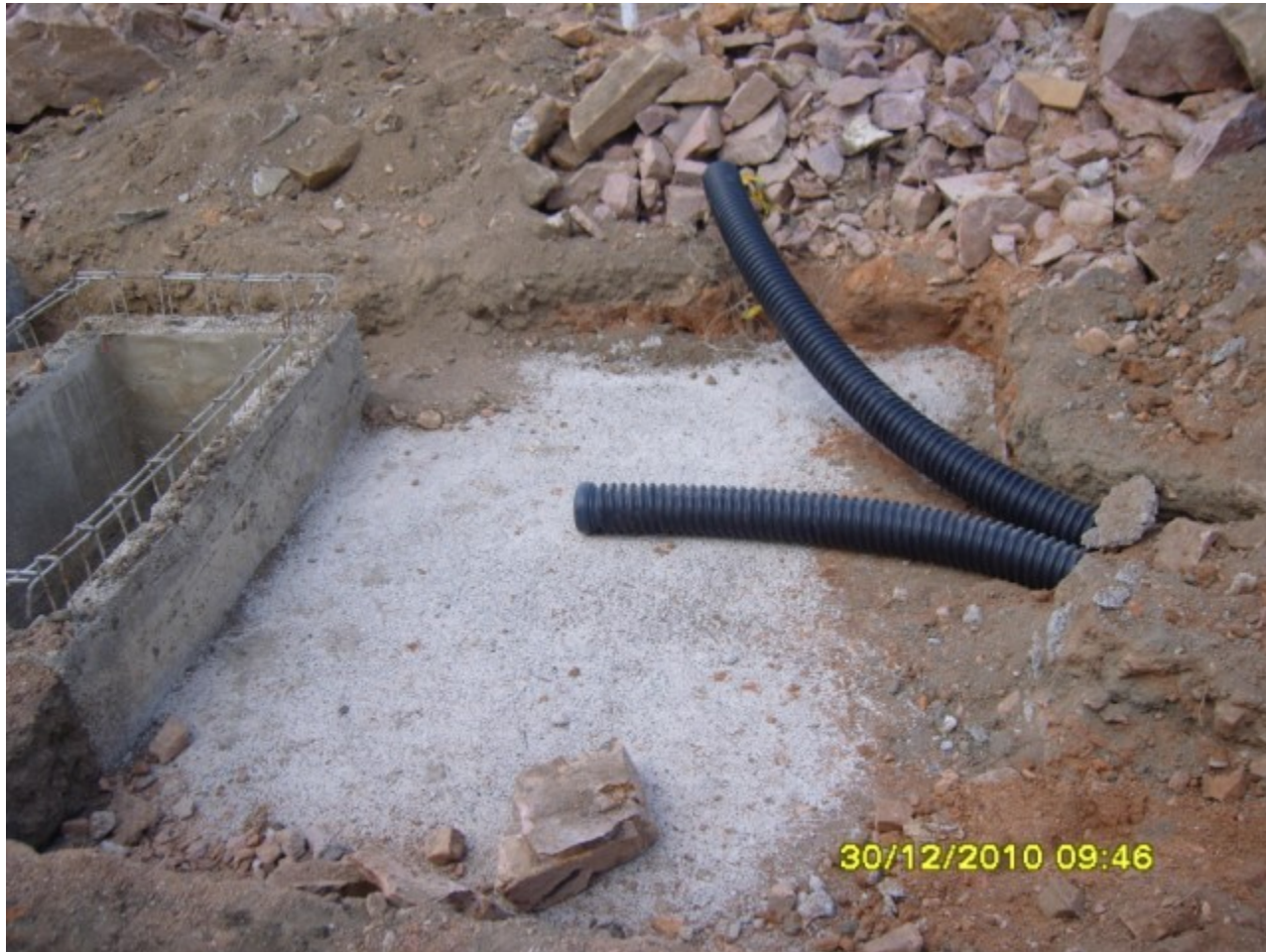
Dia 30-12-2010: Rede Subterrânea de cabos
