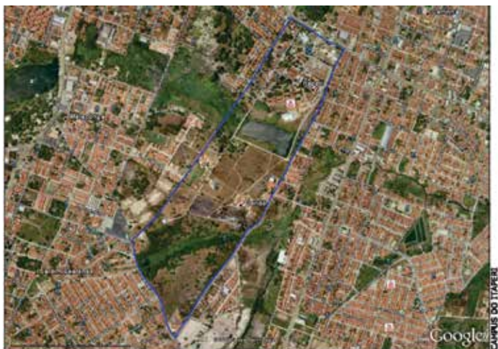
Figura 3 – Vista aérea do Campus do Itaperi, Fortaleza, Ceará.
